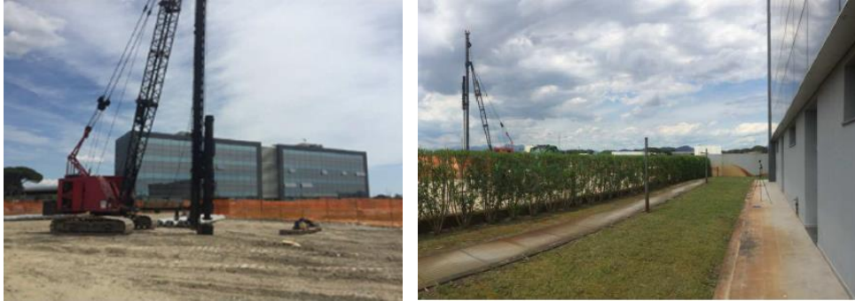
Figura 5-2. Lavorazione con battipalo e postazione di indagine
