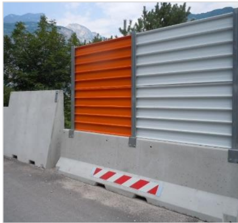
Figura 6-1. Esempio di barriera mobile altezza 2 m montata su basamento in cls
