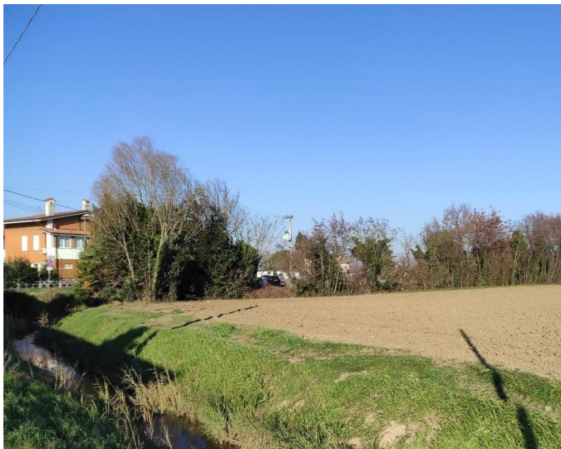
Figura 6: Tratta iniziale del cavidotto in uscita dalla cabina di consegna
